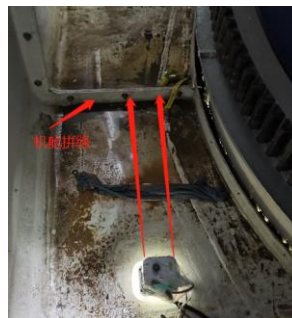
图 3-17 根据机舱内参照物调整雷达指向
