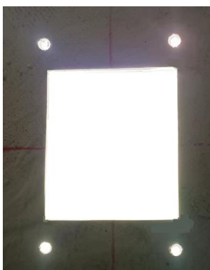
图 3-10 切割开孔、打孔
