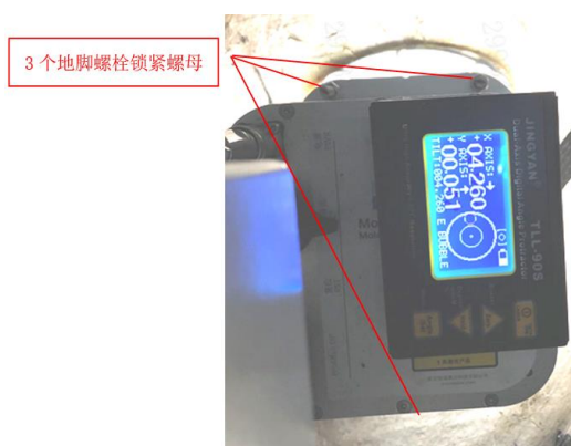
图 3-22 地脚螺栓姿态调整
