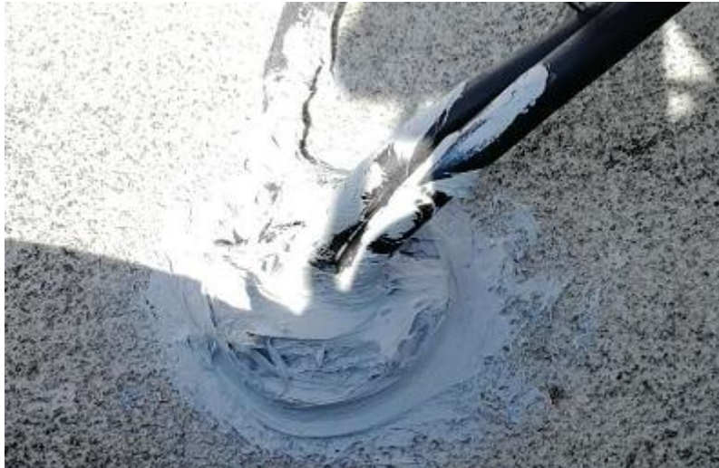
图 53 线缆过孔密封示意图
