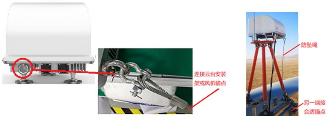
图 39 OH 防坠绳的安装
