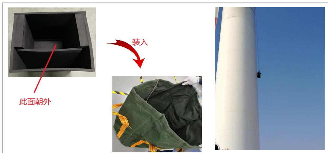
图 31 保护套装入吊装带及吊装示意图
