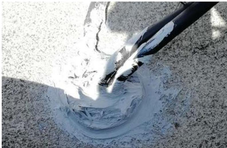
图 50 线缆过孔密封示意图
