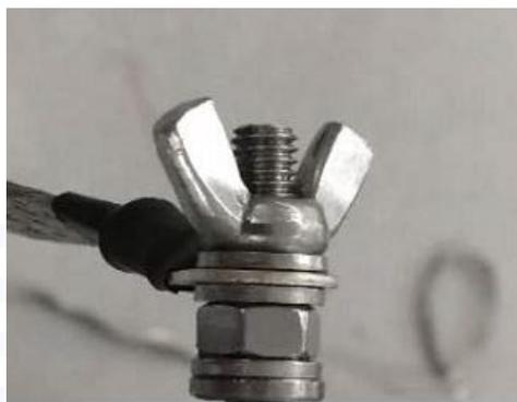
图 33 PU 接地线安装方式
