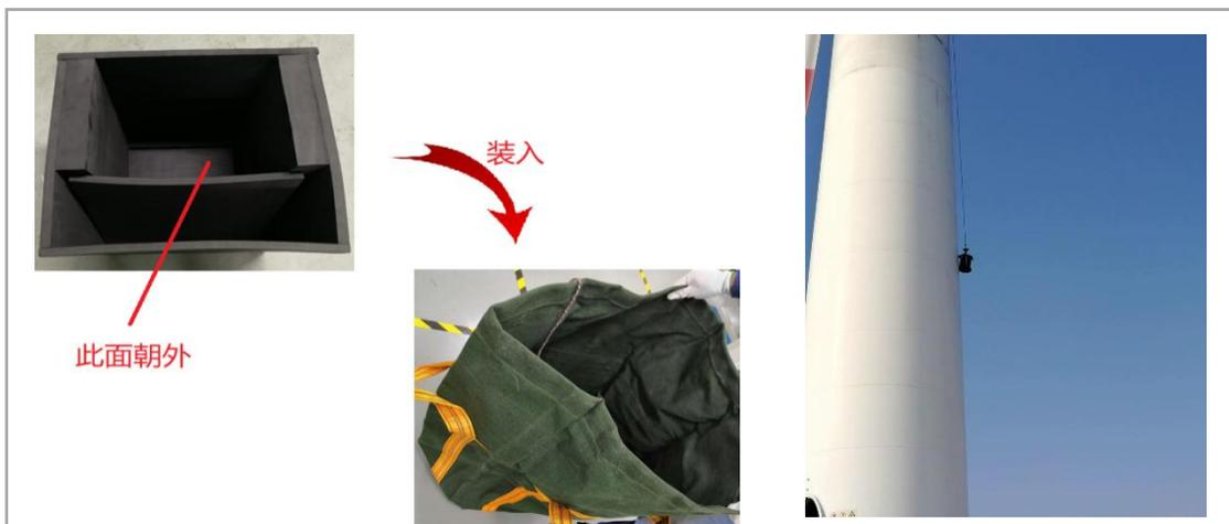
着吊装袋放入。雷达放入前注意清理保护套内异物、轻拿轻放，避免损坏雷达外表面和镜片。
